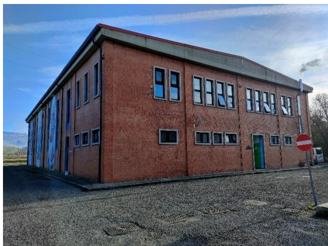
Angolo Ovest dell'edificio.
