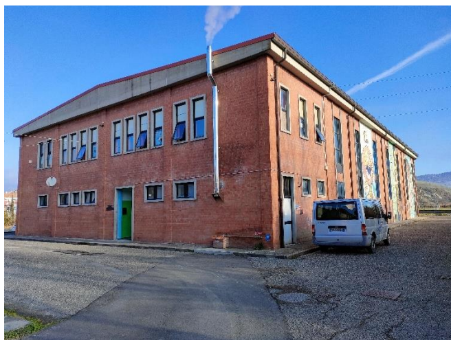
Angolo Sud dell'edificio.
